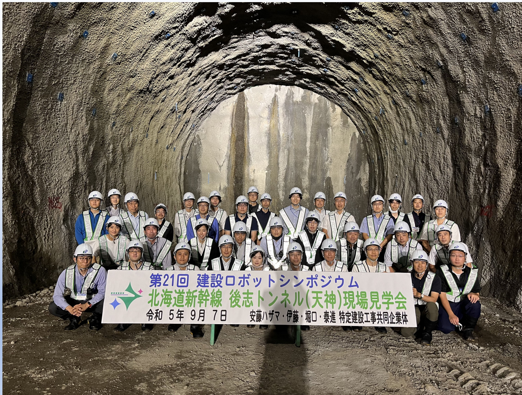
北海道新幹線後志トンネル
